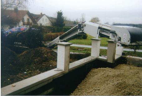
Auffüllen einer Terrasse mit Mischkies, Grundstück nicht befahrbar, kein Kran. Das Material wird mit dem LTB von der Strasse aus hochgefördert.
