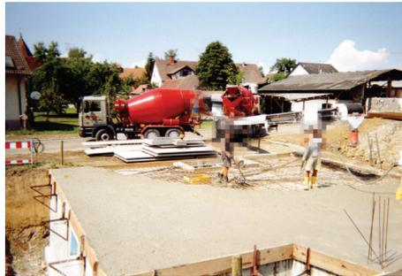
Auch bei dieser **Kellerdecke** wird der Beton von den nachfolgenden Fahrmischern ohne Band über das LTB des ersten Fahrmischers eingebracht.
