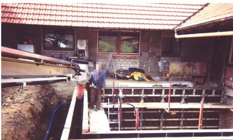
Dank der **feinfühlig**en Steuerung kann das LTB exakt an der Kellerschalung entlanggeführt werden.
